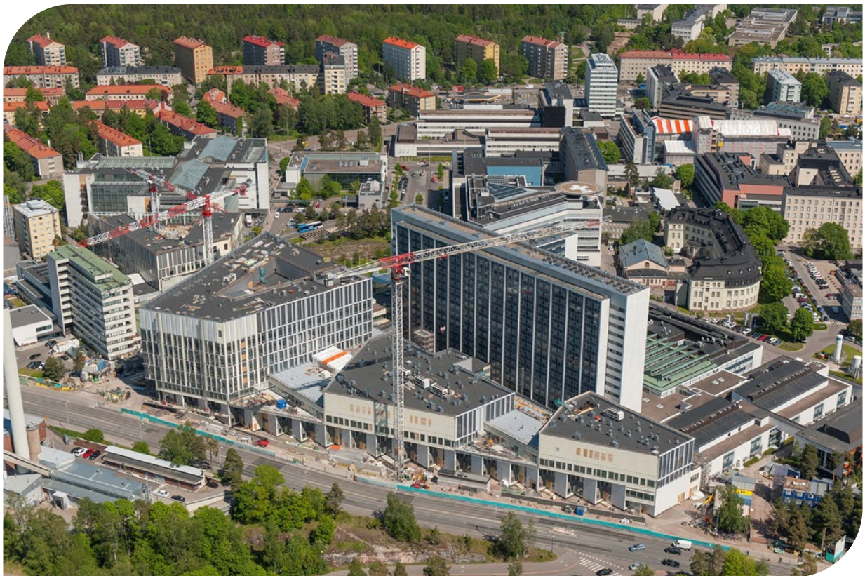
Kuva 11. Meilahden Tornisairaala (kuvassa keskellä) rakenteilla olevan Siltasairaalan takana. Kuva © HUS / Lentokuva Vallas Oy.
