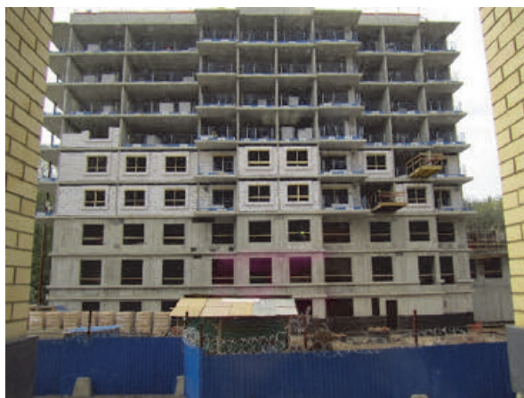
Pietarin kasvu edellyttää uusia rakennuksia ja vanhojen korjausta. Kuva: Anniina Tuomi
