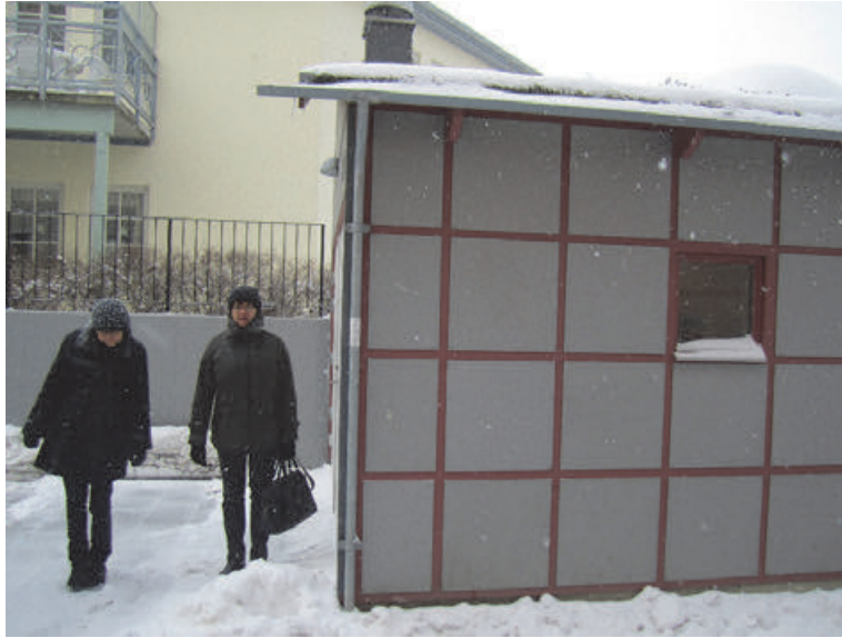
Kierrätysastiat on sijoitettu pienten rakennusten sisälle. Rakennuksilla on viherkatot. Kuva: Anniina Tuomi
