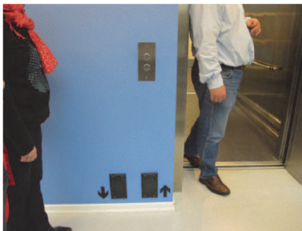
Käytävätiloissa on näkövammaisen liikkumista helpottava kontrastiraita kohokuvioineen ja hissit voidaan ”kutsua” pyörätuolin pyörien avulla. Kuvat: Hannele Lampo
