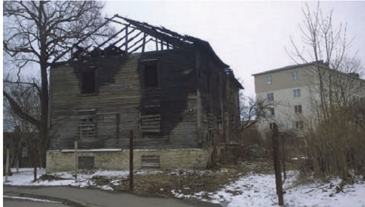
Palaneista puutaloista kerätään korjausrakennusmateriaaleja. Kuva: Anniina Tuomi
