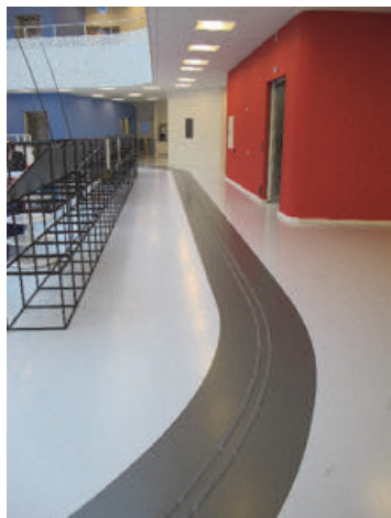
Käytävätiloissa on näkövammaisen liikkumista helpottava kontrastiraita kohokuvioineen ja hissit voidaan ”kutsua” pyörätuolin pyörien avulla. Kuvat: Hannele Lampo
