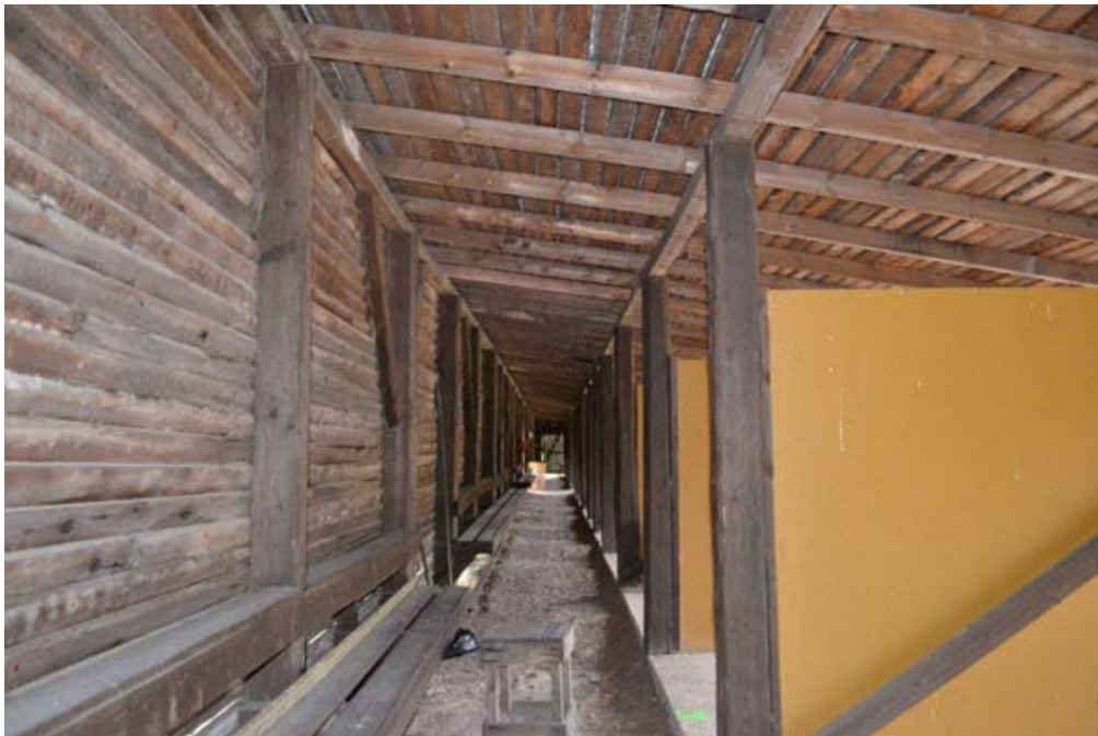
Pienoiskivääriradan ampumarakenteita (Santahaminan ampumaradat yleissuunnitelma 2013)
