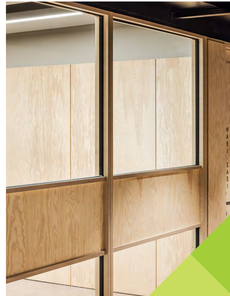
Kaikukadulla toteutettiin kokeilu, jossa käytöstä poistettuja ikkunoita käytettiin sisätiloissa väliseiniä. Kuva: Martin Sommerschild
