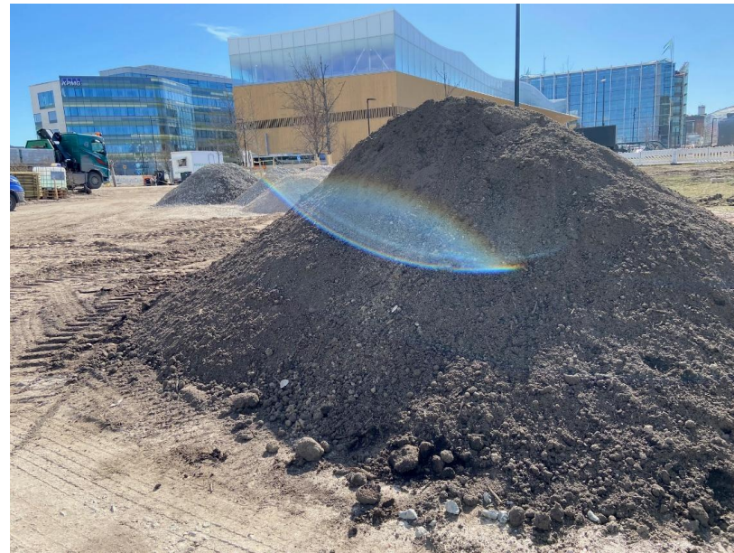
Kierrätyskasvualustaa Töölönlahdenpuiston kunnostetuille nurmikoille.
